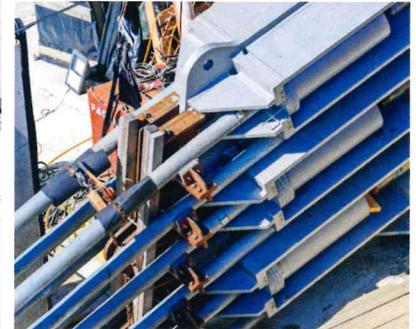
musste vorab mit den Seilkränen eine Hilfsseilbrücke aus zwei 52 mm Seilen und 40 Seilreitern errichtet werden.
