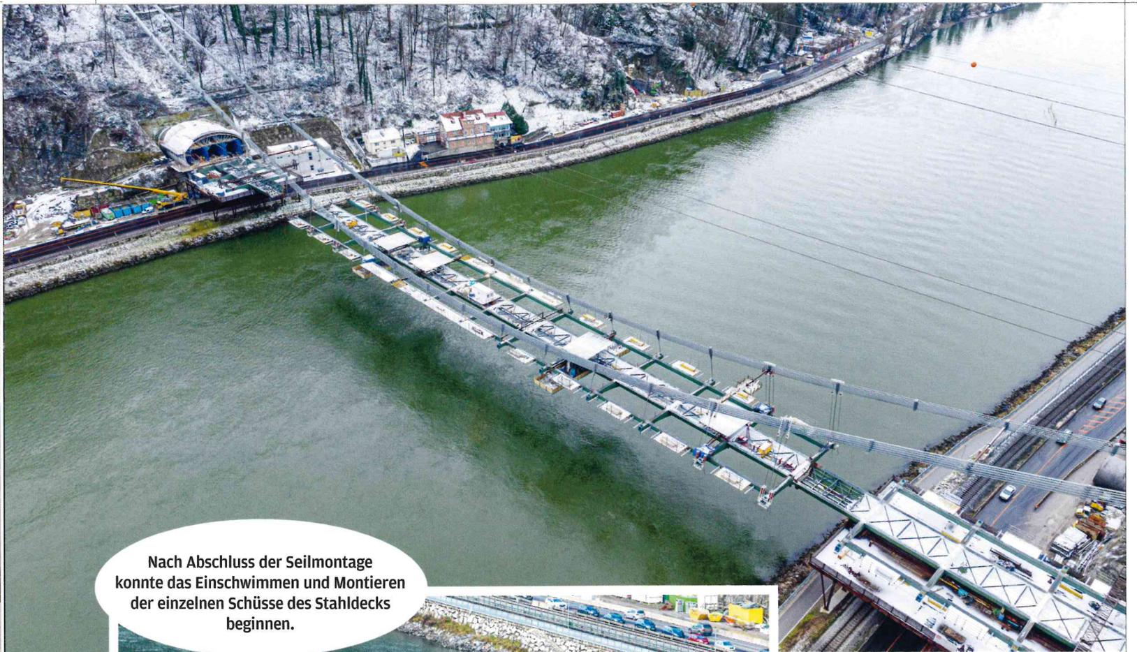
Nach Abschluss der Seilmontage konnte das Einschwimmen und Montieren der einzelnen Schüsse des Stahldecks beginnen.
